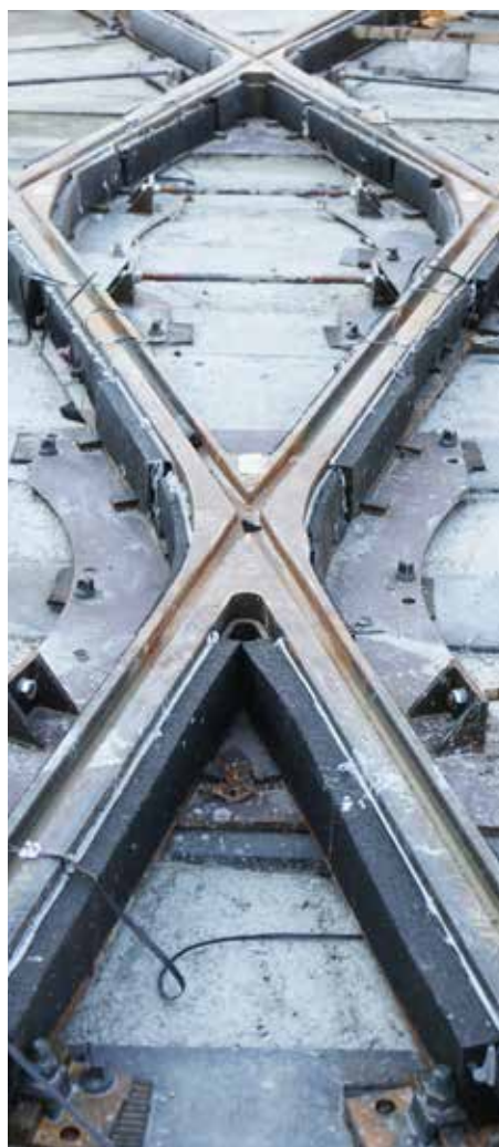
Beépített keresztezési középrész burkolás előtt
