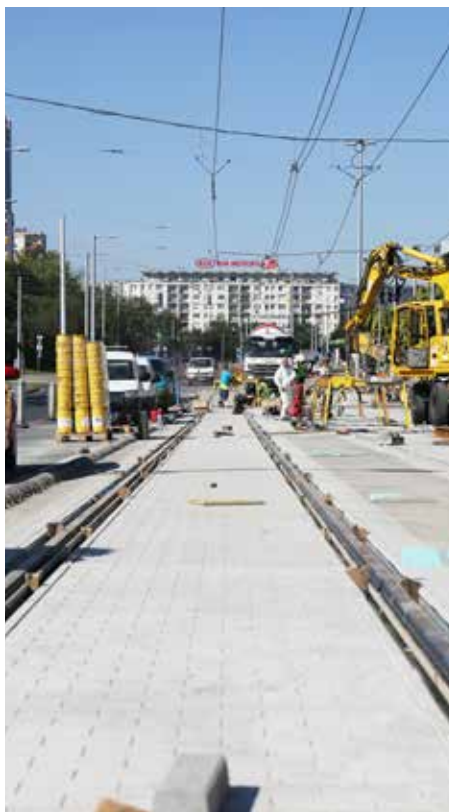
Az előregyártott vasbeton pályaelemekbe elhelyezett sínek a körülöntésre várnak
