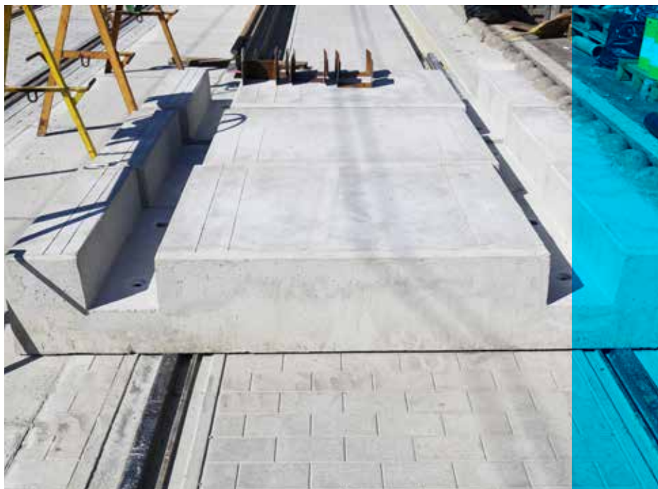
Előregyártott vasbeton pályaelem
